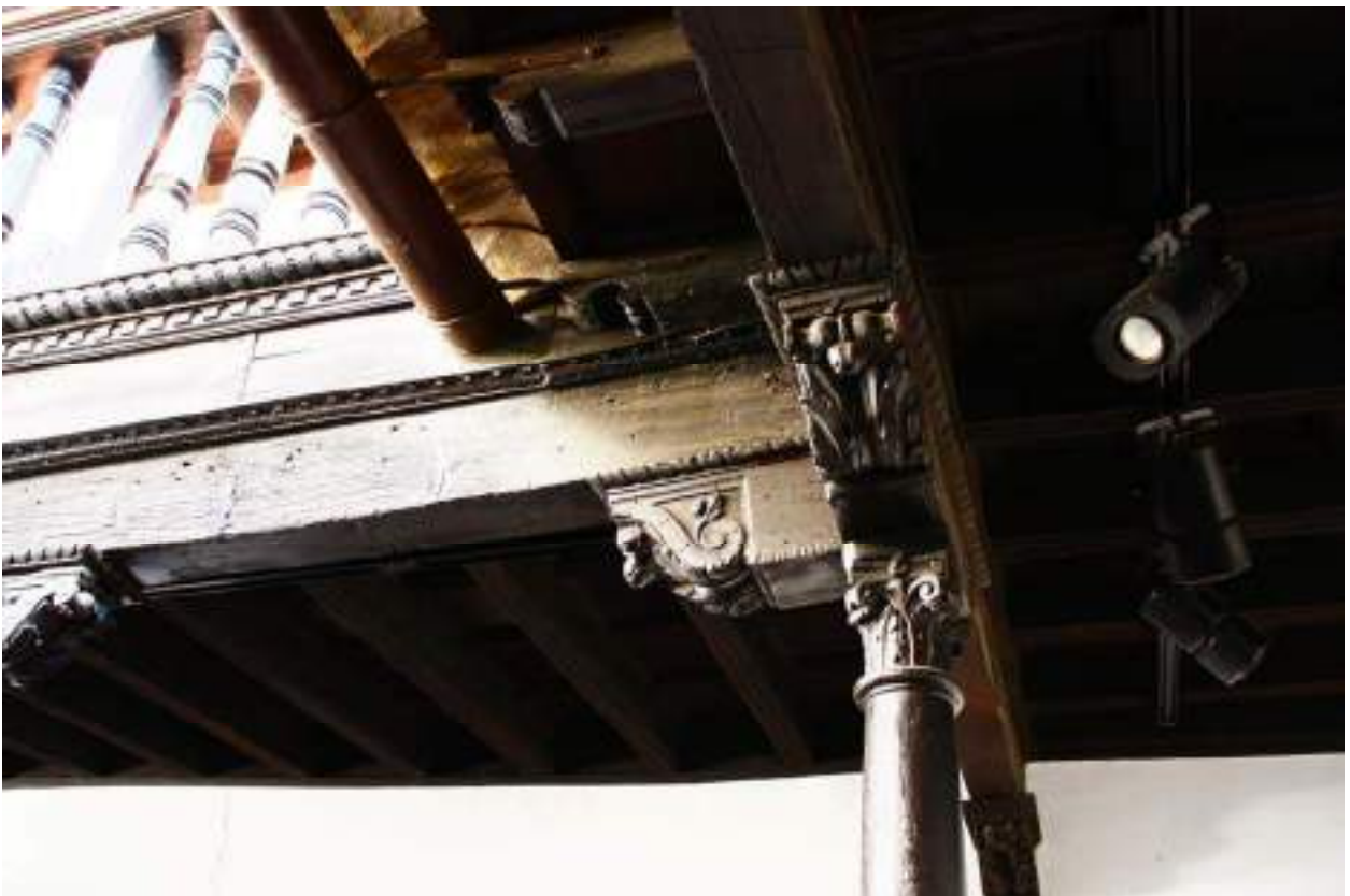
Pies derechos del primer nivel de galería. Detalles. Fotos del autor.
