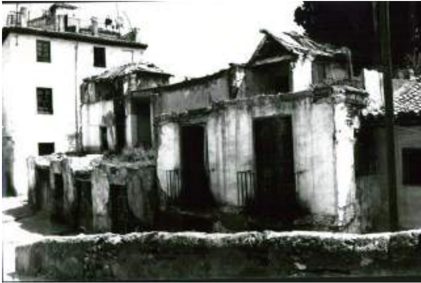
Vista de las viviendas hacia la cuesta de San Gregorio, demolidas por la intervención del arquitecto Prieto Moreno, fotos históricas, 1968 ca., Archivo General de la Administración.
