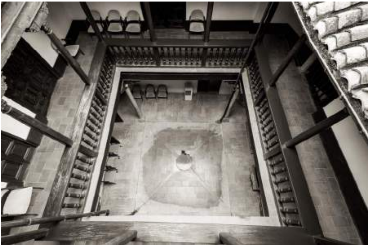
Vista superior del patio principal, desde la planta segunda. Fotos Víctor Ramon Ballesta
