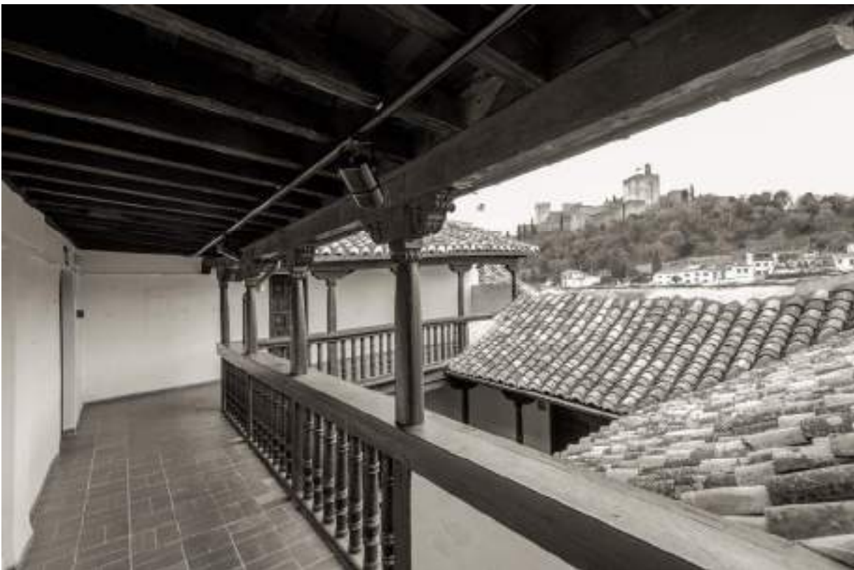
Segundo nivel de galería, planta superior. Fotos Víctor Ramón Ballesta
