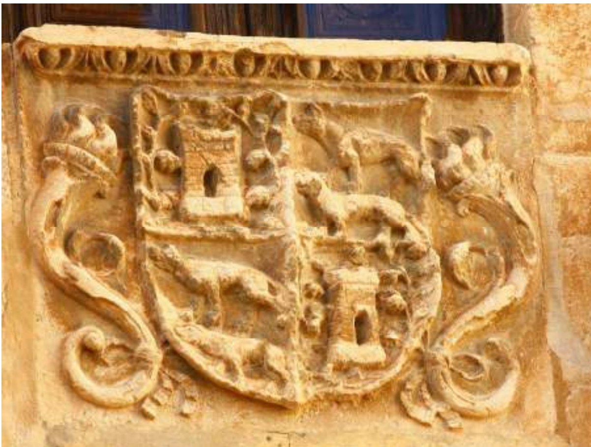
Casa de Porras. Escudo en la portada principal, formando el antepecho del ventanal principal. Estado actual. Foto del autor.
