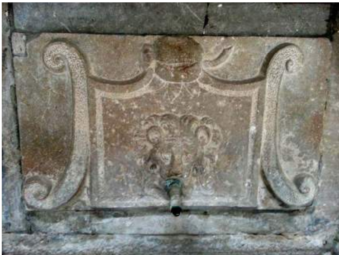
Casa de Porras, pilar del patio central.
