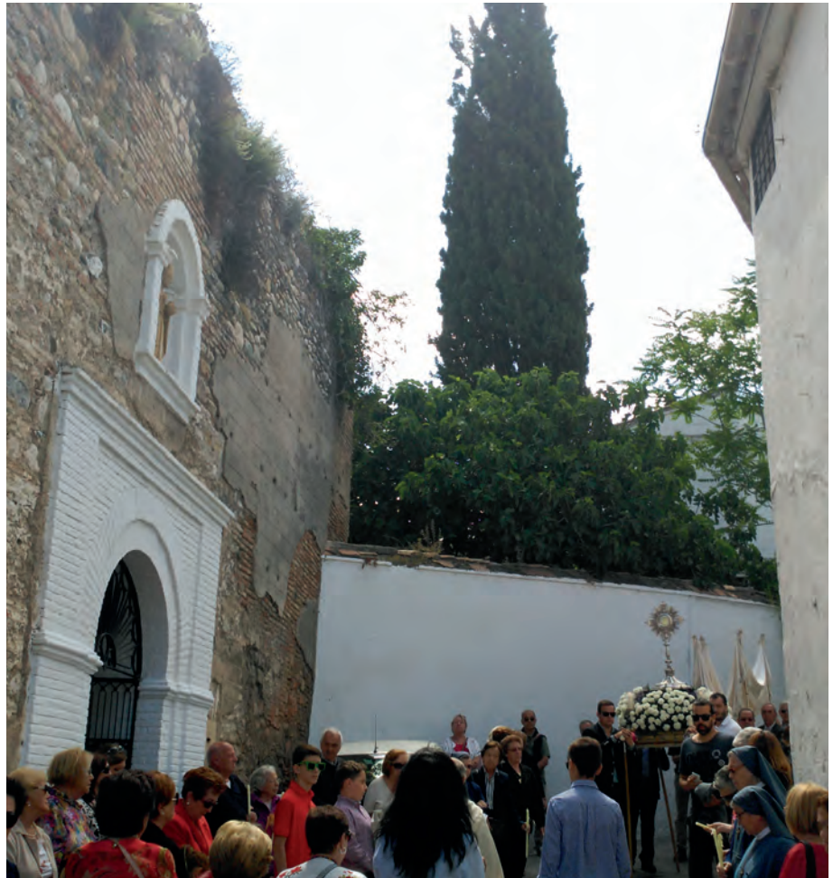
Fig. 3. Capilla de San Cecilio en la puerta de Hernán Román, antes de ser restaurada. Fotografía de Miguel García-Valdecasas Rodríguez.
