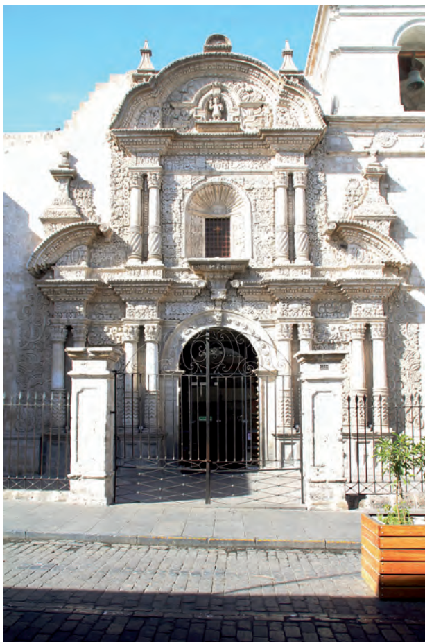
Fig. 4 Iglesia de la Compañía de Jesús de Arequipa, fachada, 1698 Foto del autor.
