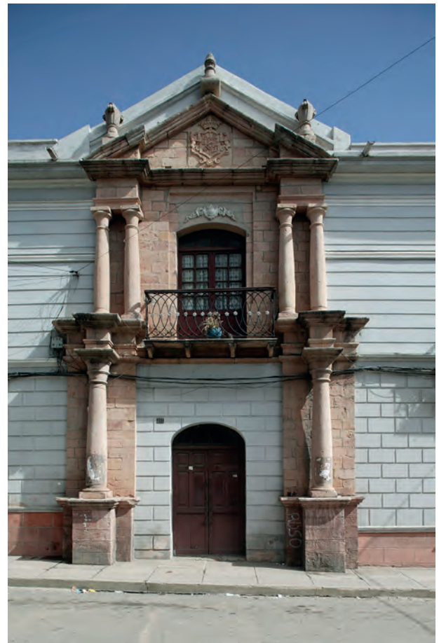
Fig. 4. Portada casa de Torre Tagle. Fotografía de la autora, 2020.
