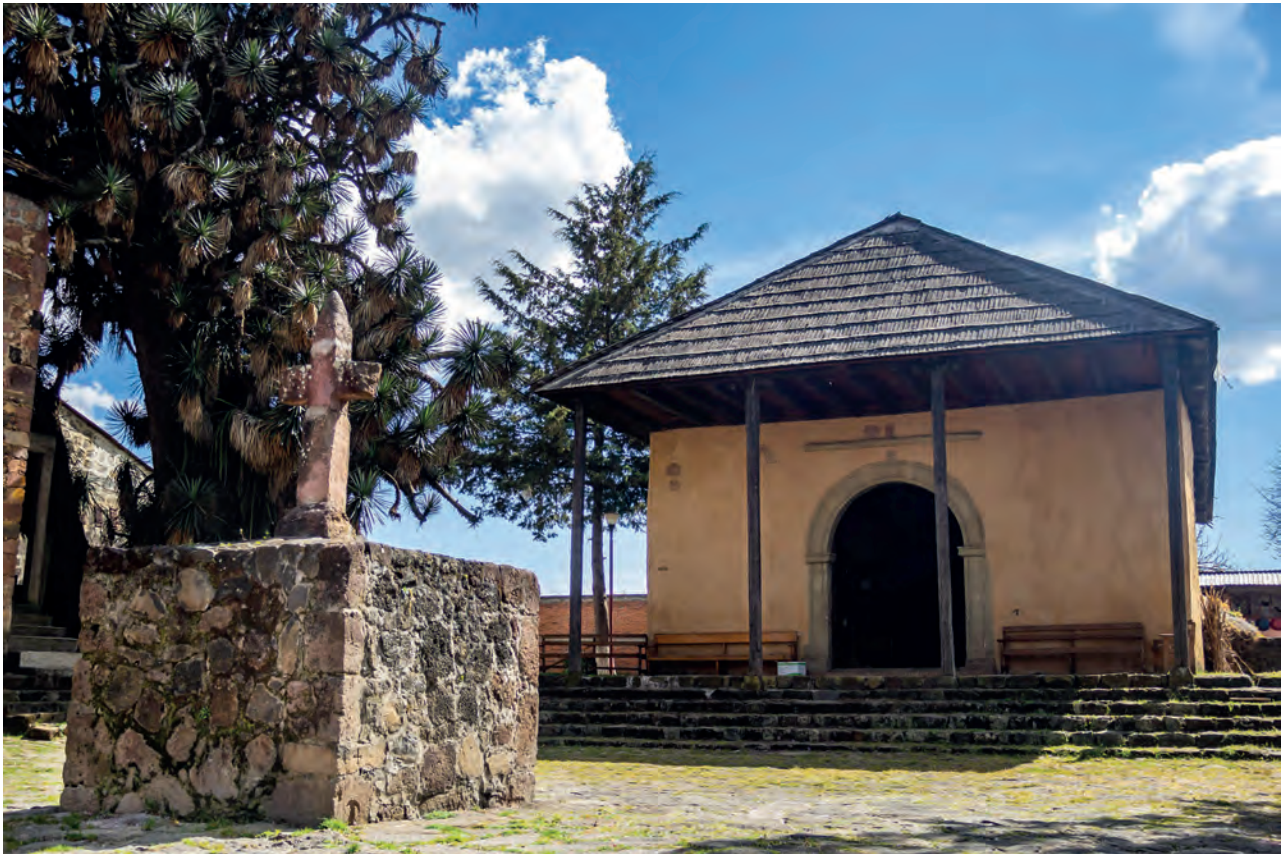
Fig. 1. Capilla de la huatápera de la Inmaculada Concepción de Nurio. Michoacán. México. Fotografía digital de Ulises Cárdenas, 2020.
