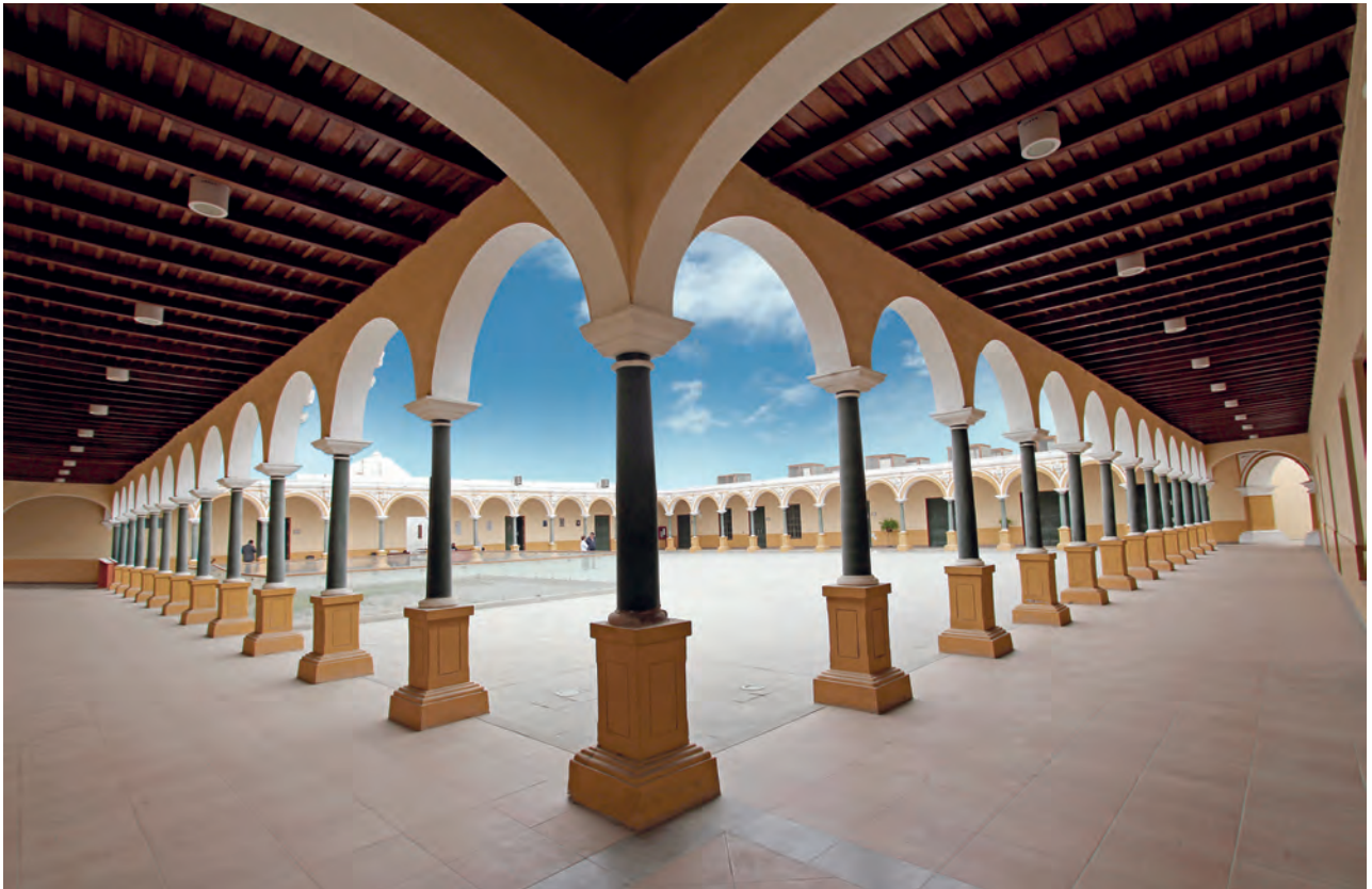
Fig. 3. Galerías claustrales y patio del antiguo colegio San Luis Gonzaga. Ica. Perú. Fotografía de los autores, 2019.
