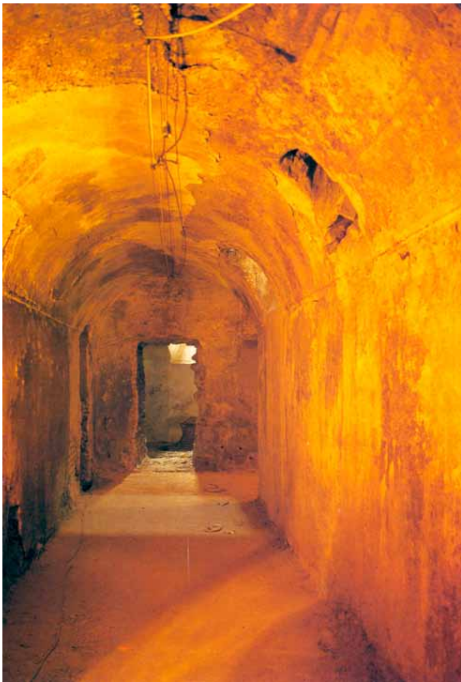
Edificio de la antigua Universidad. Detalle del sótano en el que se encontraba el aljibe.
