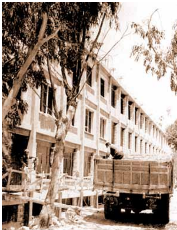
Parte trasera del nuevo edificio en la fase final de su construcción (1967)
