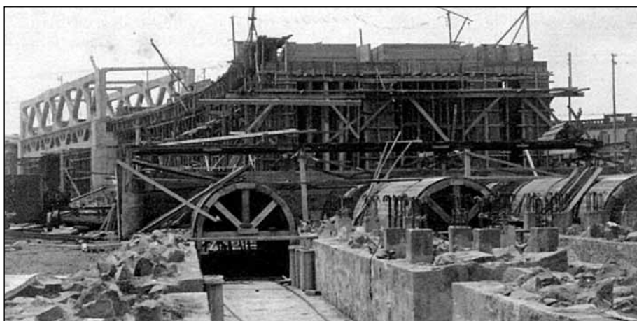
Obras de construcción del cargadero de mineral de la CEMR
