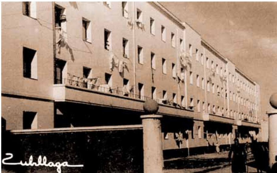
Grupo de viviendas General Orgaz
