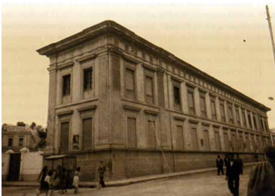
Nave derecha de la Escuela General y Técnica, la única que se construyó
