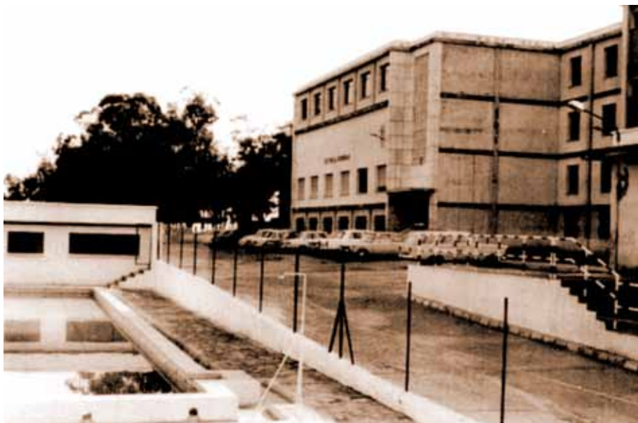
La Escuela Normal en los inicios de los años setenta con la piscina de 25 m.
