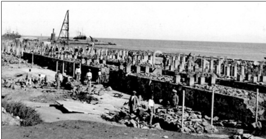
Los trabajos del puerto provocaron conflictos laborales en tiempos republicanos
