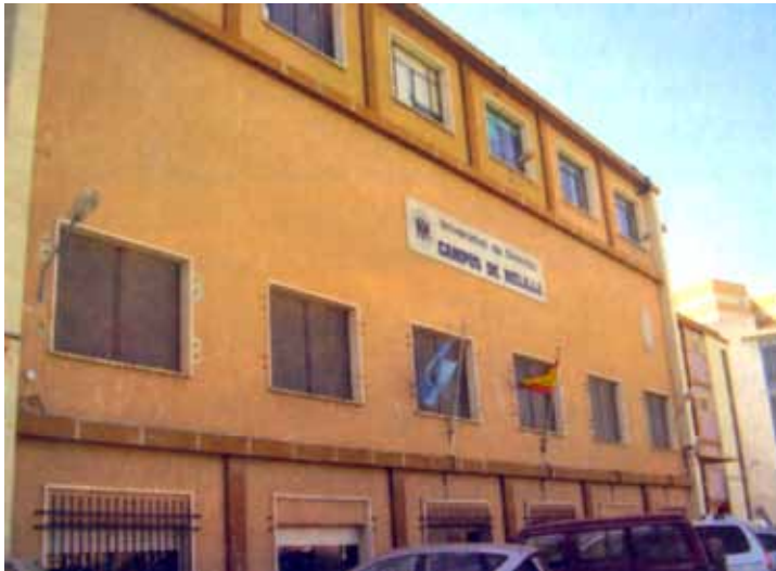
Fachada del edificio principal del Campus, de los años sesenta del pasado siglo
