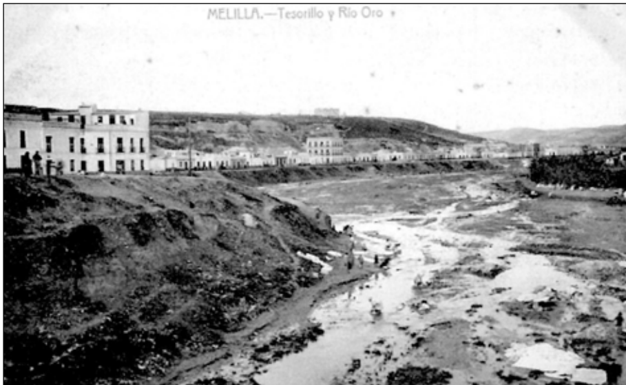
Cauce del río de Oro, cuyo desvío fue proyectado en la República
