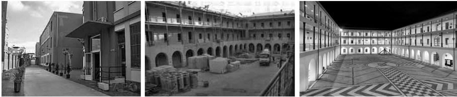
Figura 2. Antiguo edificio de la Facultad de Educación y Humanidades en el Morro (izquierda). Obras de reacondicionamiento del acuartelamiento Tte. Ruiz (centro). Instantánea nocturna del nuevo campus universitario de Ceuta (derecha).
