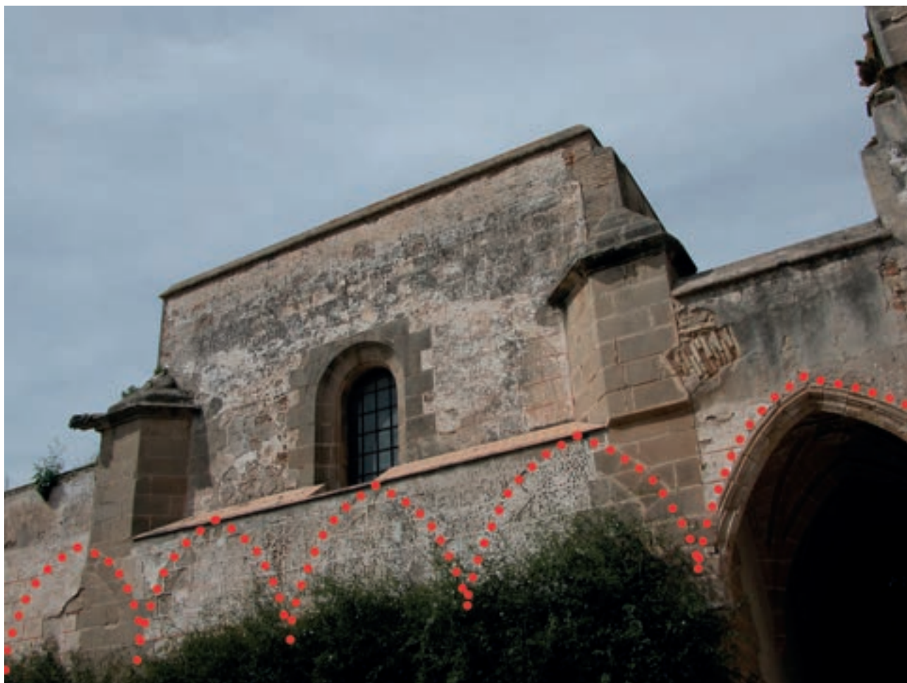
Fig. 15-6. Entrega del antiguo Corredor al Patio de los Jazmines, donde se aprecian los enjarjes y huellas de formeros correspondientes a las bóvedas de la Galería entre el Claustro Chico y la Cocina. Fotografía del autor
