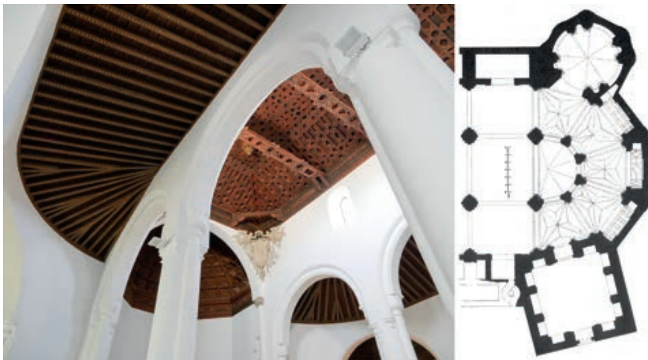
Fig. 20-6. (a) Vista general de los techos de la iglesia de Santiago en Guadix (fotografía de los autores). (b) Planta de la cabecera de la catedral de Guadix (de Gómez-Moreno Martínez 1983, 79)
