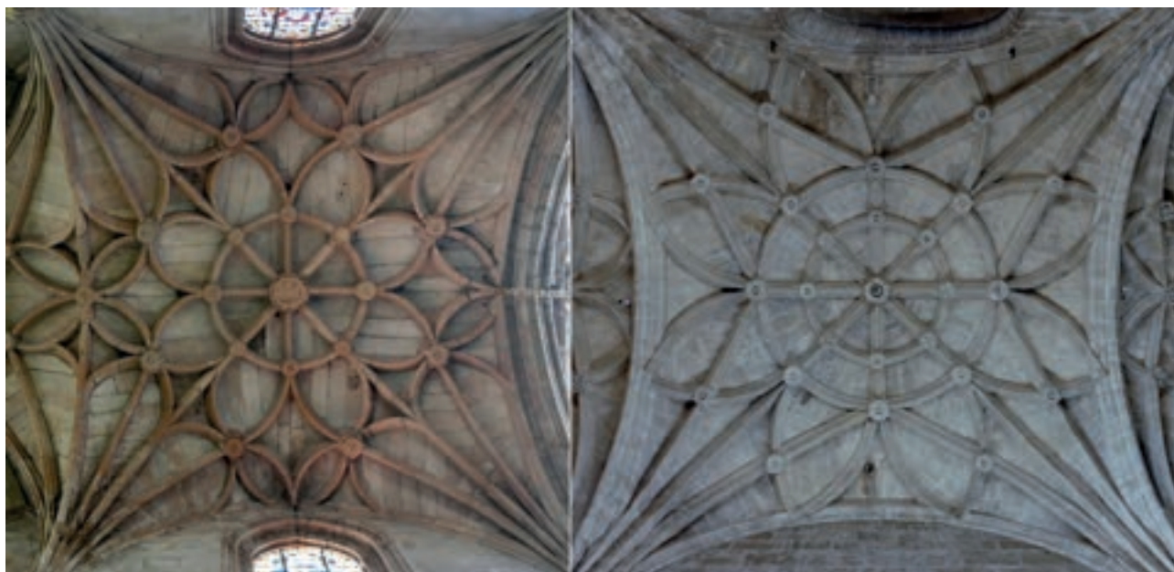
Fig. 11-6. (a) Bóveda de la cabecera de la catedral de Braga y (b) bóveda central de la sacristía de los Cálices de la catedral de Sevilla (fotografías de los autores)
