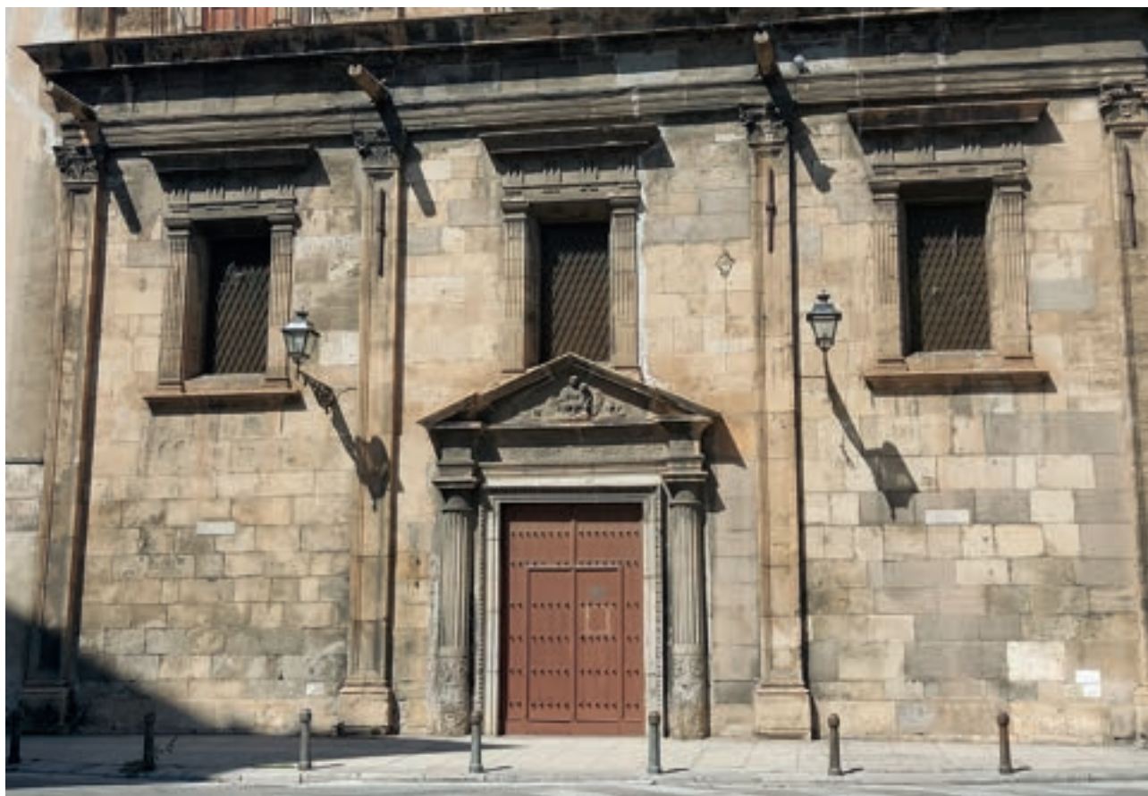
Fig. 30-3. Palermo, chiesa di Santa Maria di Portosalvo, esterno
