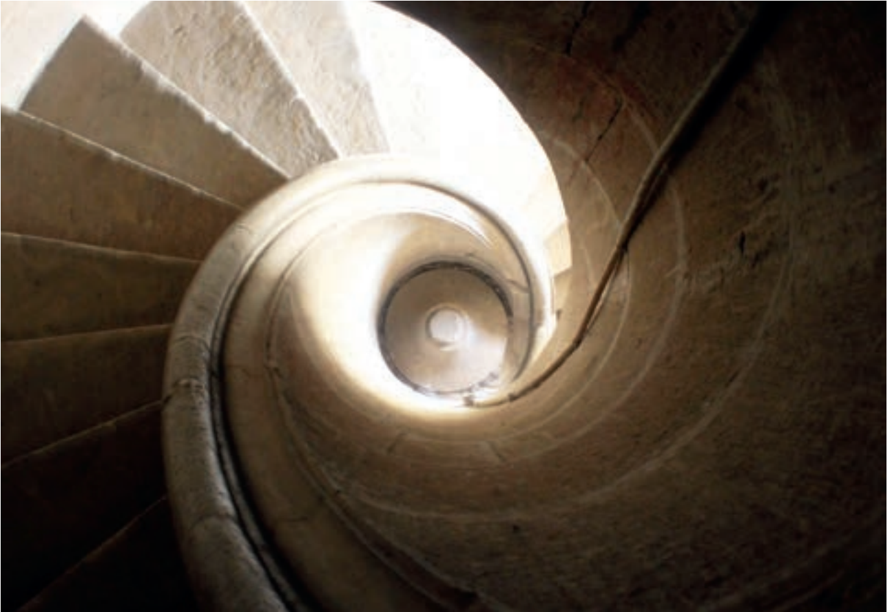
Fig. 28-1. Escalera de acceso a la torre, 1602 en adelante. Fotografía de la autora
