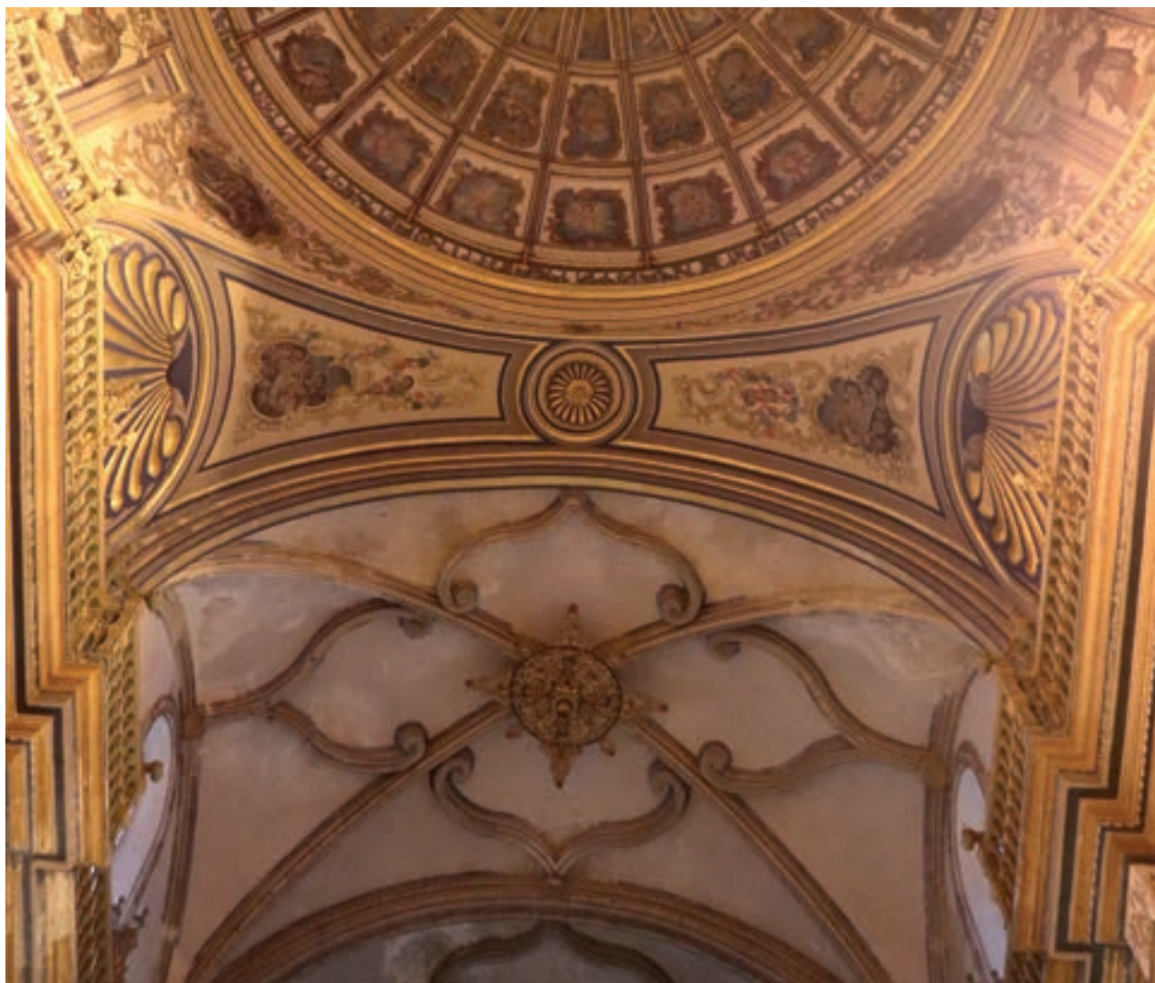
Fig. 29-5. Arco de transición y conexión entre la capilla mayor y la nave. Fotografía del autor
