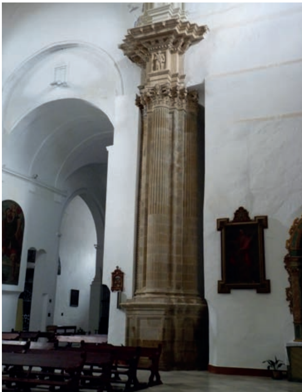
Fig. 18-6. Muro de cierre de los pies de la nave del Evangelio de la ampliación renacentista
