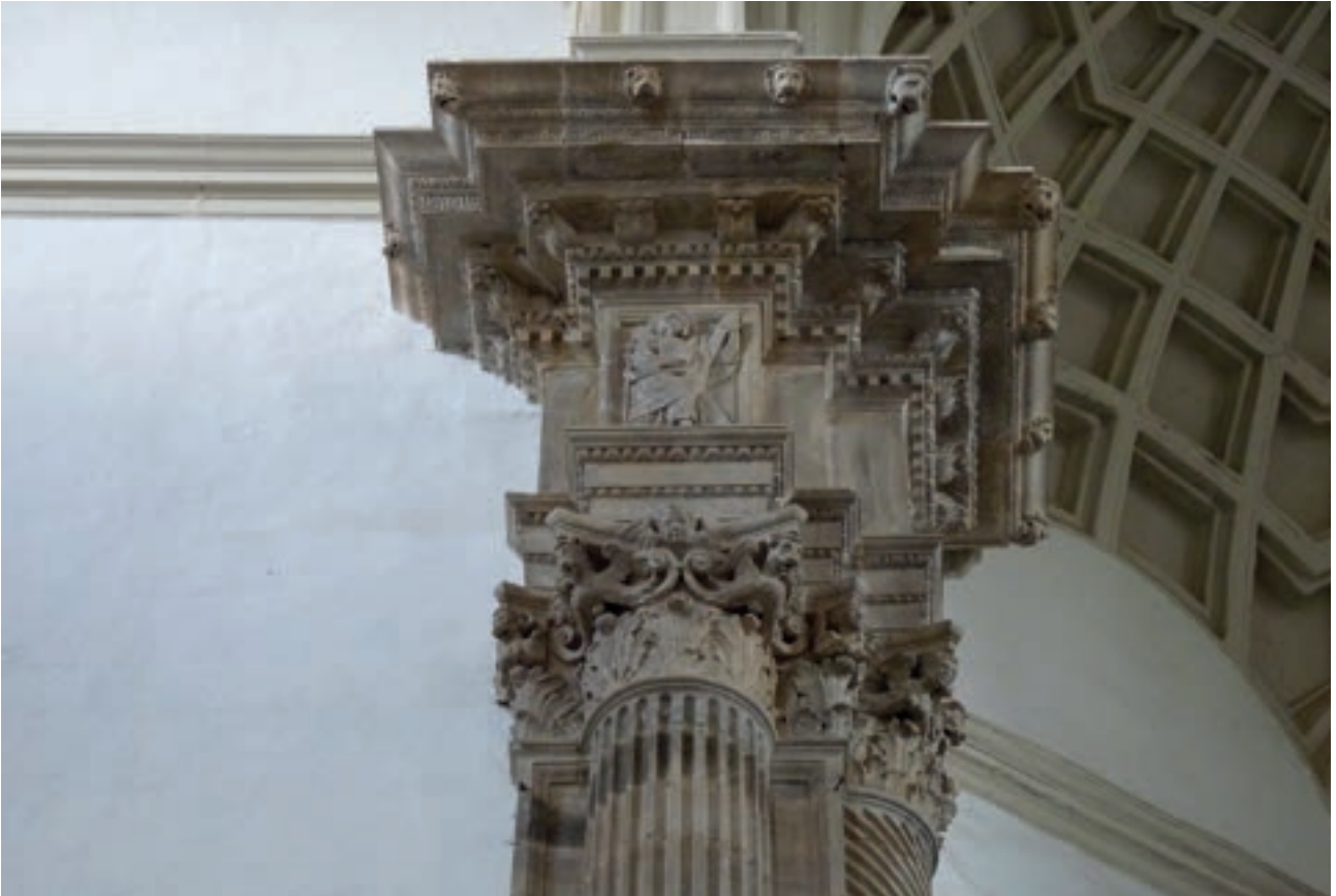
Fig. 18-3. Capitel y entablamiento de remate del pilar del arco toral del presbiterio, lado del Evangelio
