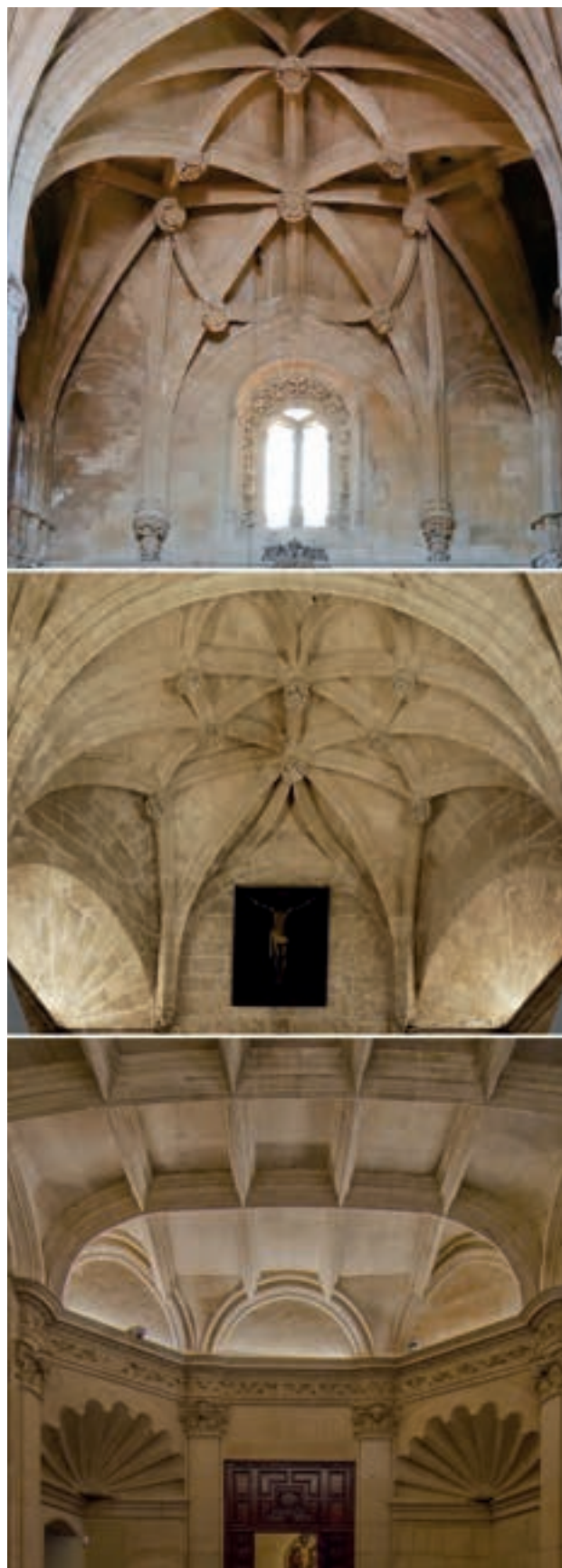
Fig. 11-8. Soluciones abocinadas de bóvedas en sus apoyos murales: (a) naves laterales de Santa María de Arcos de las Fronteras, (b) sacristía de los Cálices de la catedral de Sevilla y (c) sala de Fieles Ejecutores del ayuntamiento de Sevilla (fotografías de los autores)
