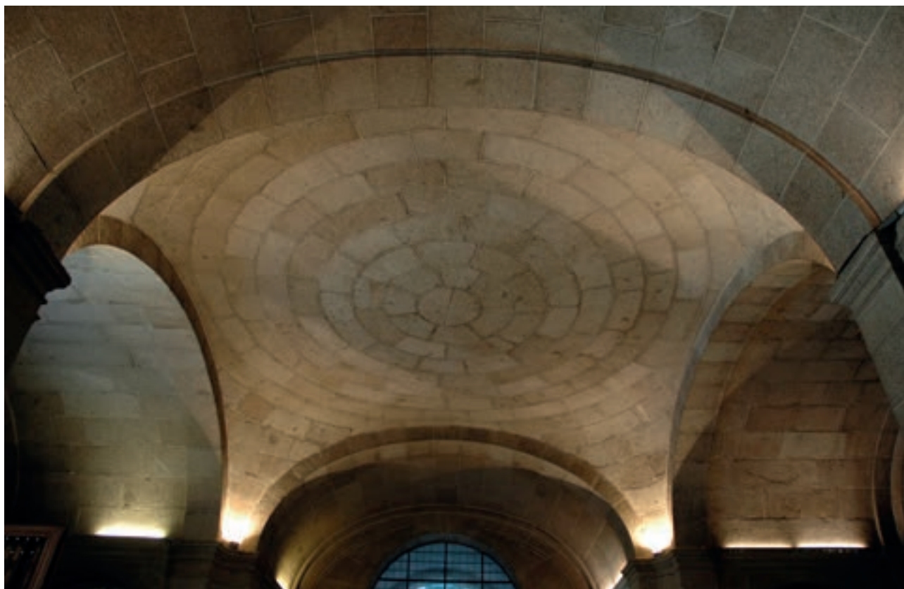
Fig. 2-9. Bóveda del sotacoro de la iglesia de San Lorenzo de El Escorial. Juan de Herrera (1563-1586). Fotografía del autor
