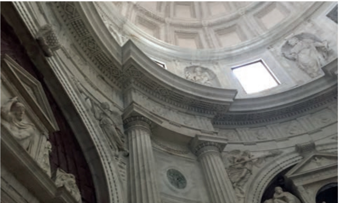
Fig. 23-5. Cappella Caracciolo di Vico. Diego de Siloe. 1514-1518 prima fase. Sviluppo curvilineo delle arcate su pilastri. Fotografia dell'autrice
