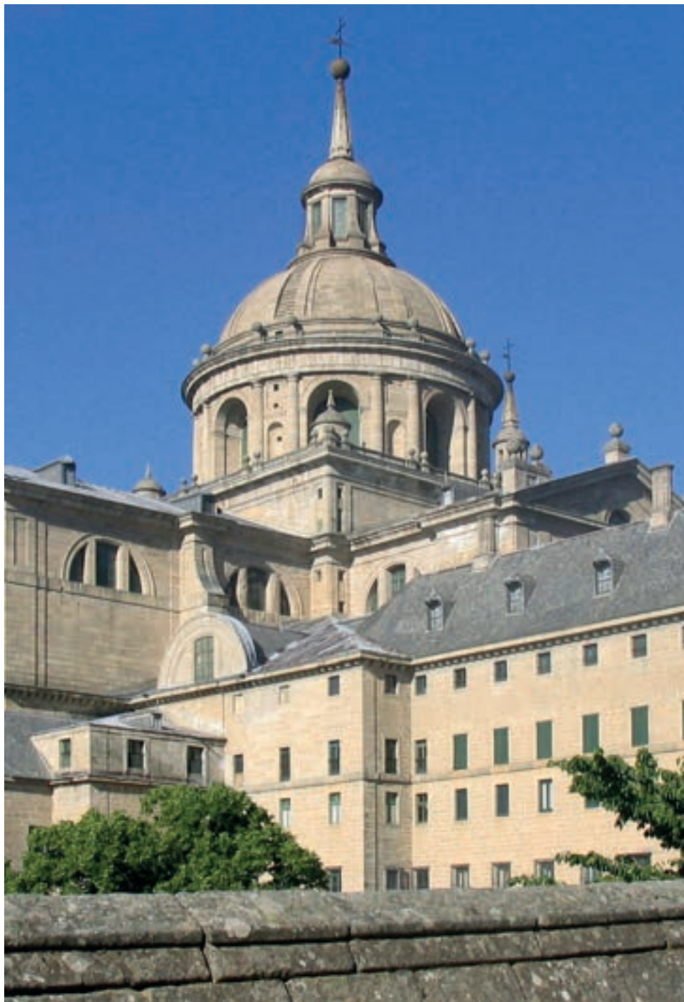
Fig. 2-10. Cúpula central de la iglesia de San Lorenzo de El Escorial. Juan de Herrera (1563-1586). Fotografía del autor
