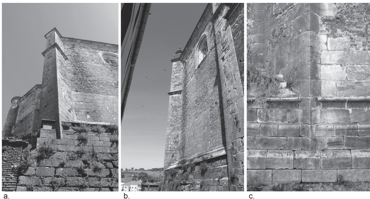
Fig. 14-2. Basamento y fábrica pétrea: a. ángulo norte, b. costado del Evangelio, c. encuentro costado de la Epístola-sacristía. Fotografías del autor
