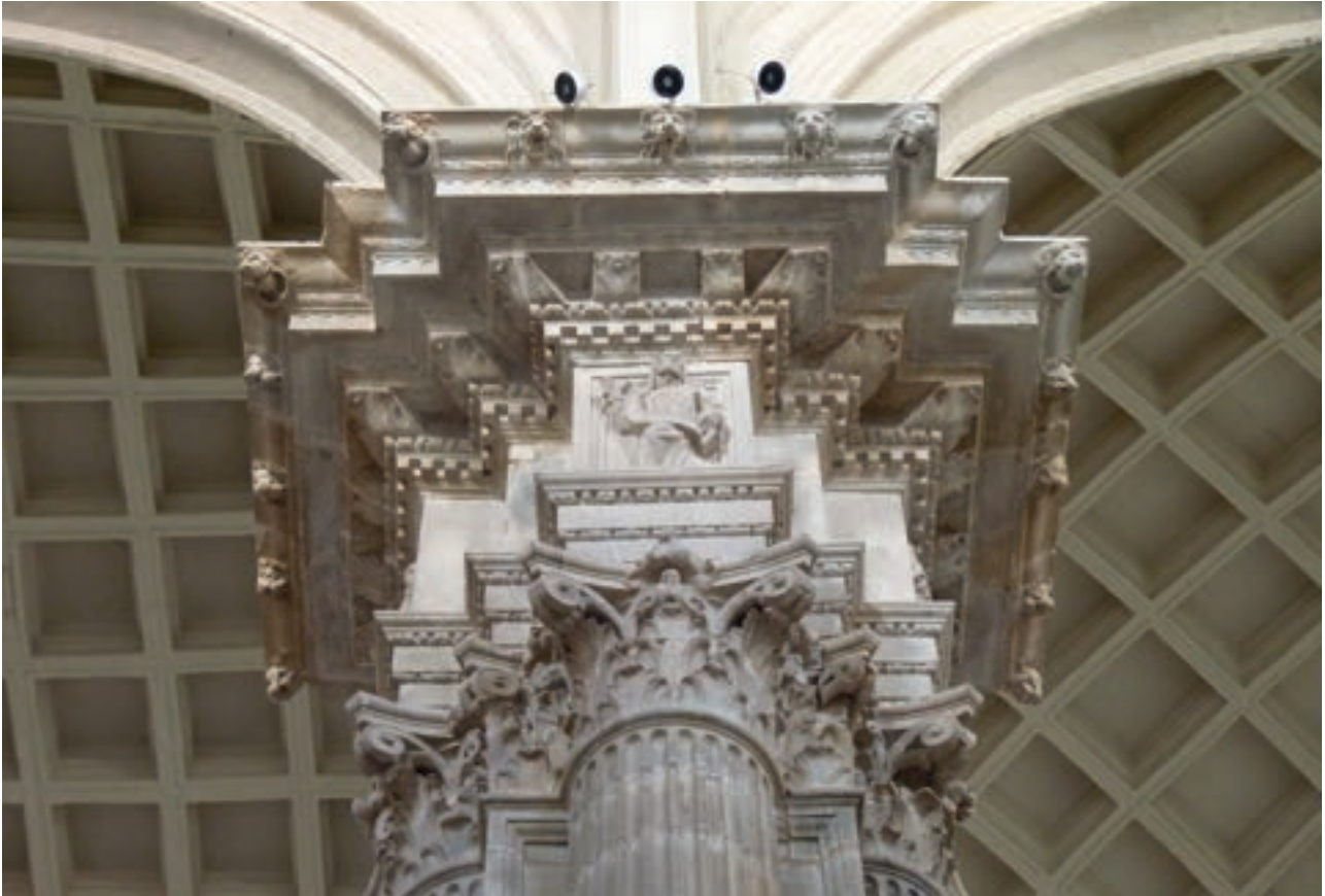
Fig. 18-4. Pilar de separación de los tramos entre las naves de la Epístola y central
