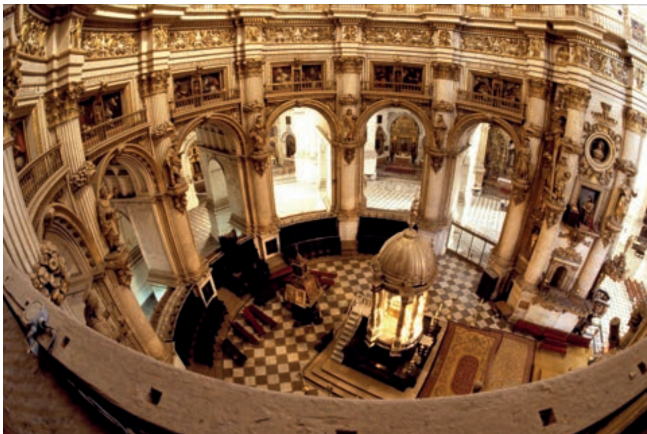
Fig. 22-5. La Capilla Mayor antes de iniciar el desmontaje del coro. Fotografía Javier Algarra, 1990
