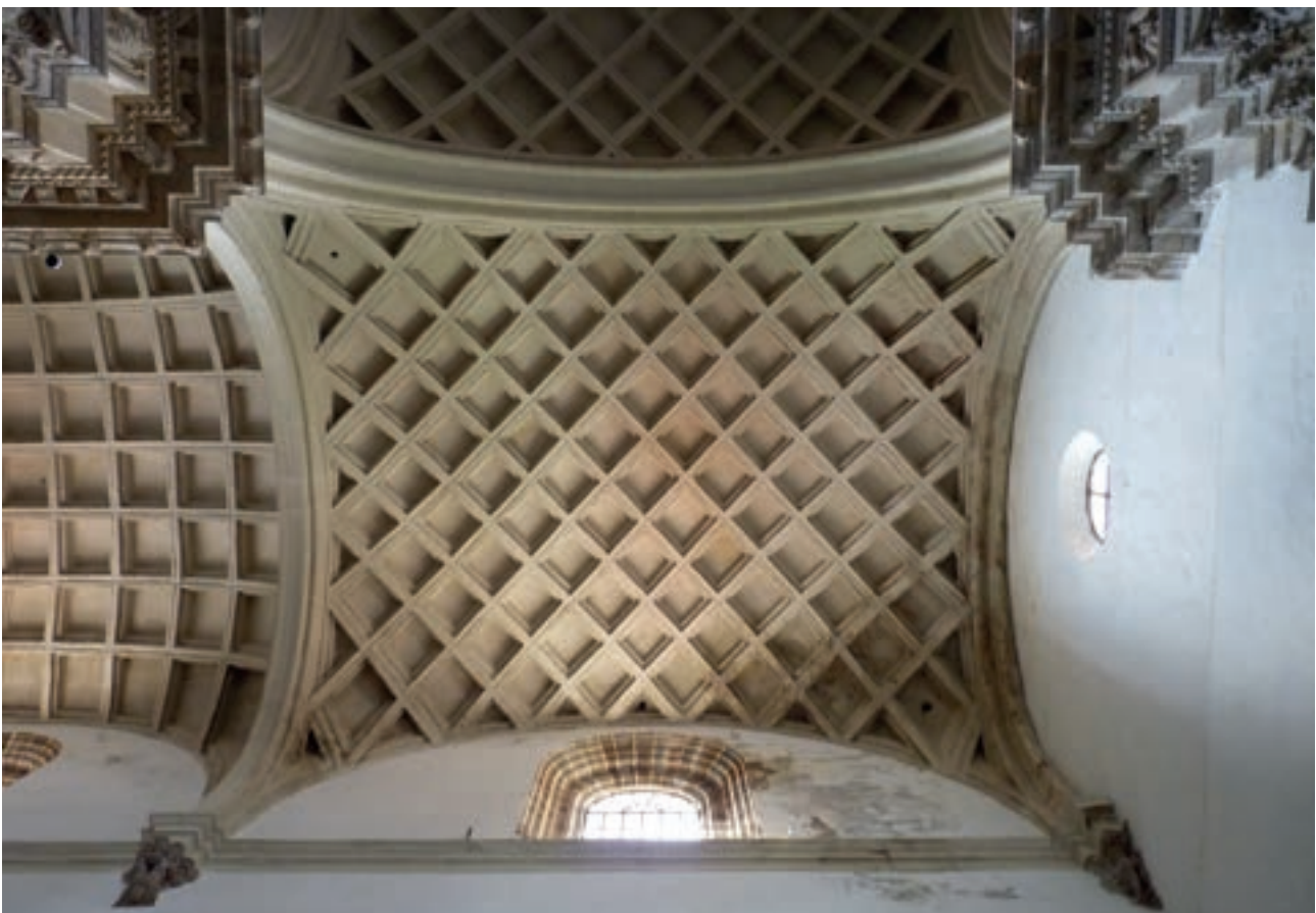
Fig. 18-5. Bóveda del segundo tramo de la nave de la Epístola
