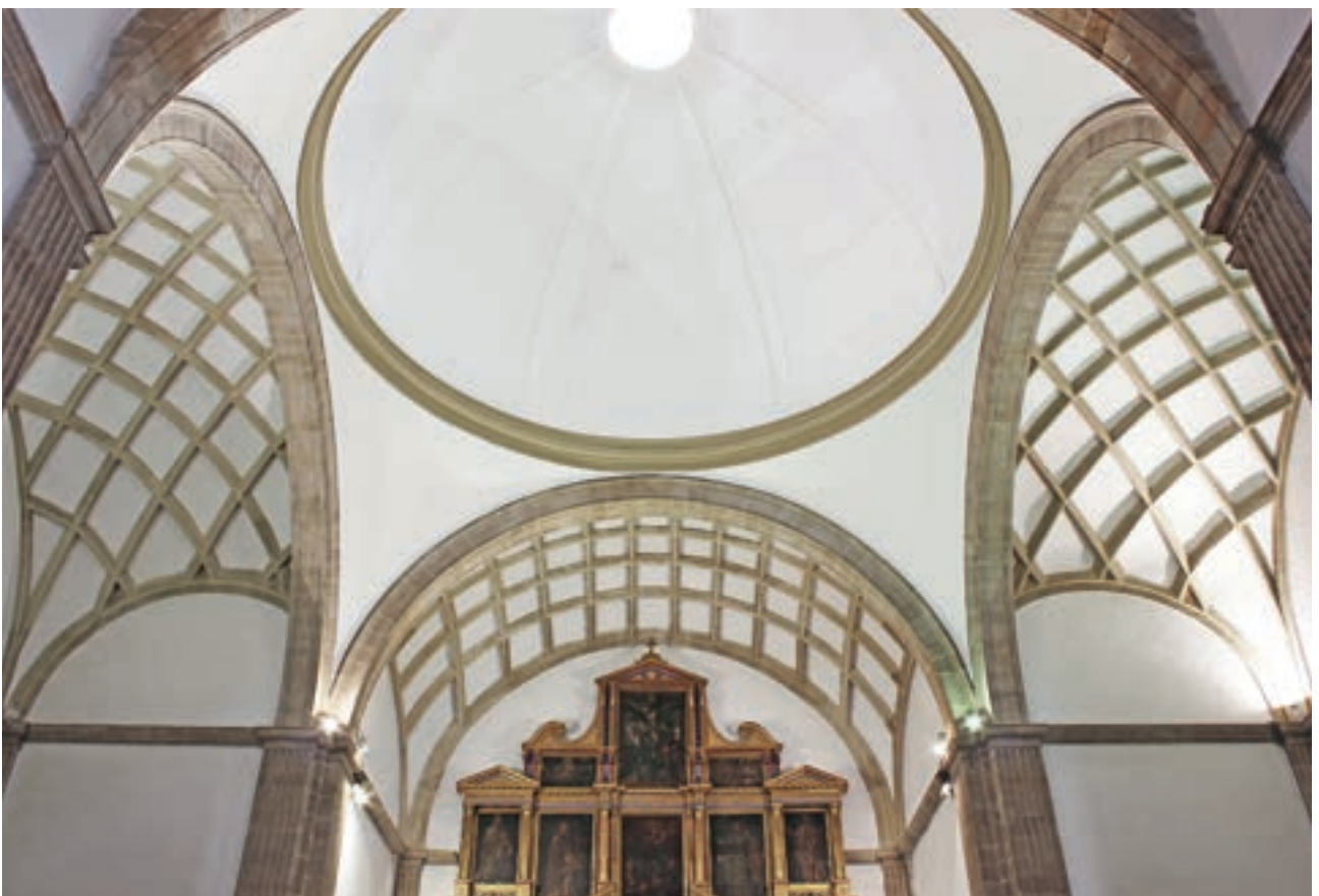
Fig. 19-2. Baídas en la iglesia de San Pedro de Montijo. Francisco de Montiel, 1605 en adelante. Fotografía del autor
