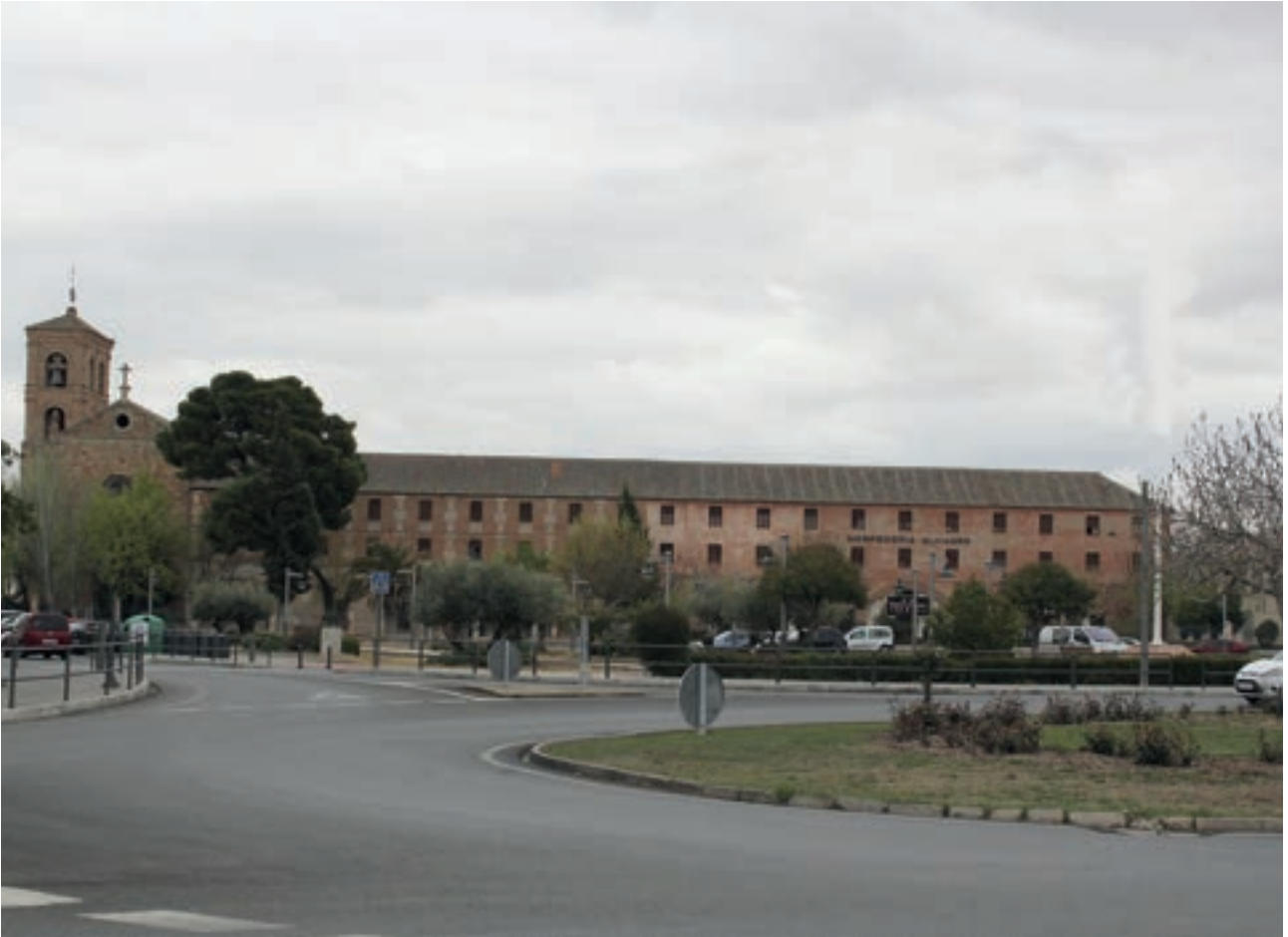
Fig. 35-2. Vista panorámica de la fachada occidental. Fotografía de los autores
