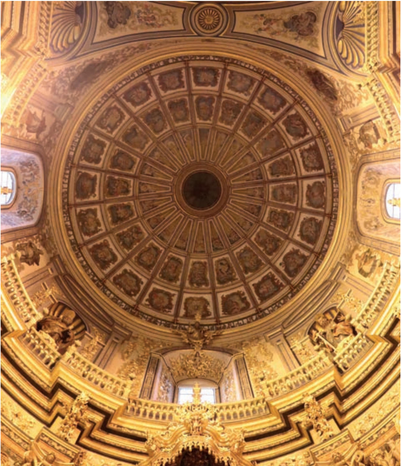
Fig. 29-4. Cúpula de la capilla mayor. Fotografía del autor
