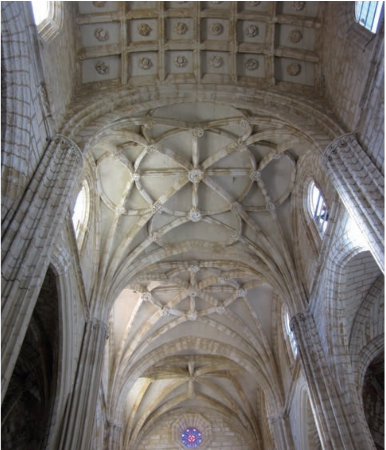
Fig. 13-2. La nave de la iglesia de San Miguel hacia los pies, tras la restauración. Fotografía del autor (2018)
