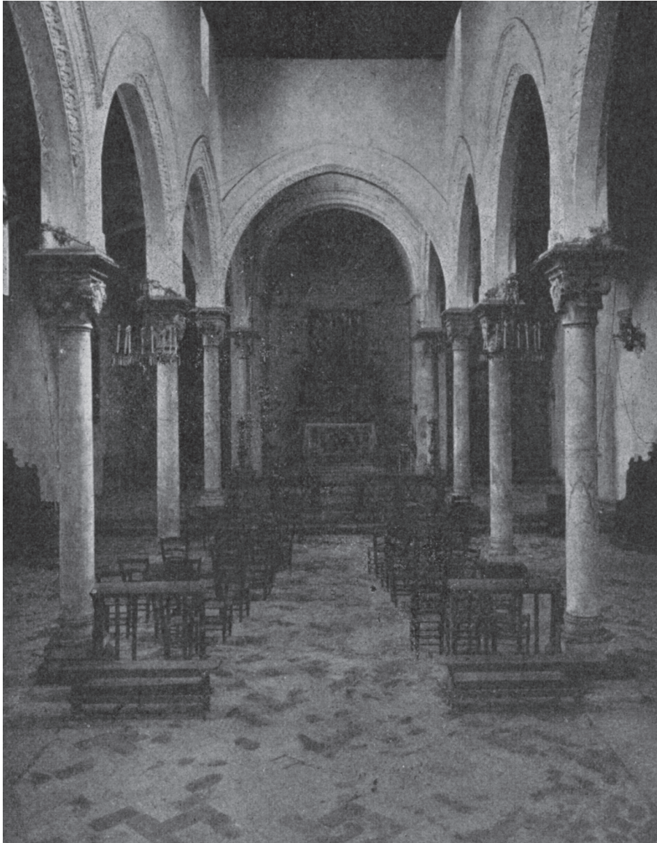
Fig. 30-1. Palermo. Interno della chiesa della chiesa dell'Annunziata (distrutta nel 1943). (Da A.Venturi, Storia dell'Arte Italiana. L'architettura del Quattrocento , vol. VIII parte seconda, Milano 1924)
