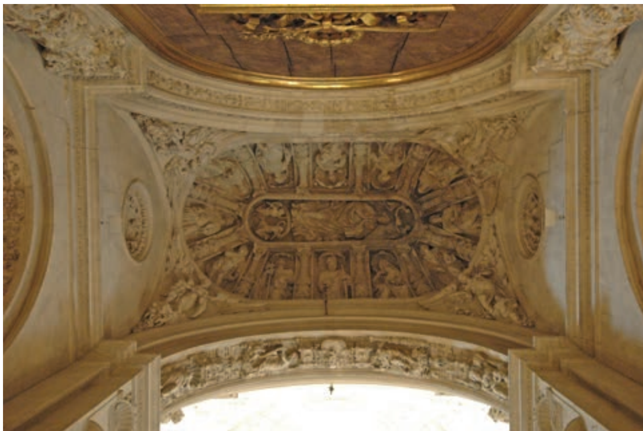
Fig. 2-7. Solución de abovedamiento del tramo central de la cabecera de la sacristía mayor de la catedral de Sevilla. Diego de Riaño y Martín de Gaínza (1528-1543). Fotografía del autor
