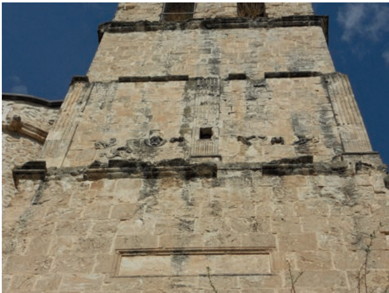
Fig. 30-5. Ciminna (Pa). Torre campanaria della chiesa madre
