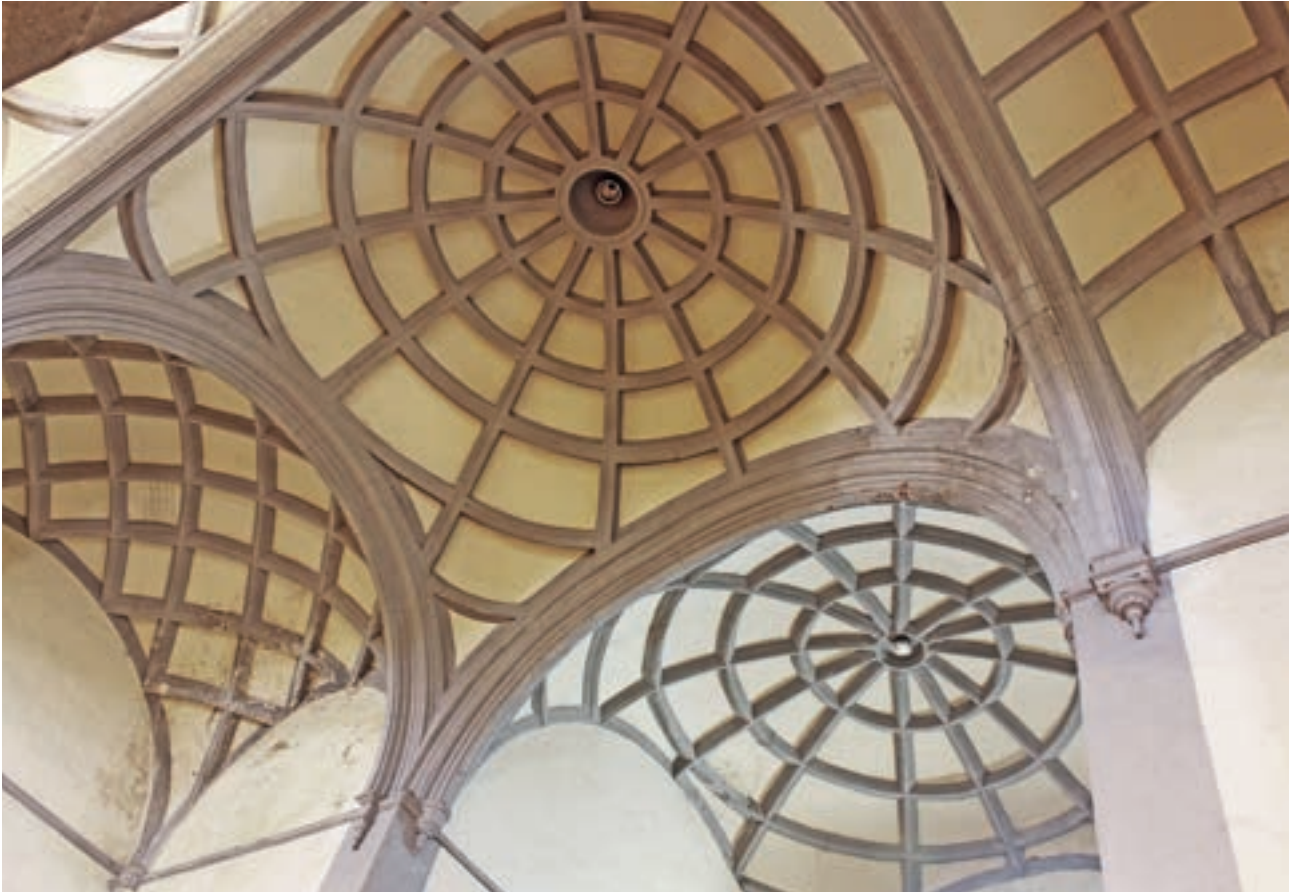
Fig. 19-1. Baídas en la iglesia del Rosario de Zafra. Francisco de Montiel, en torno a 1580. Fotografía del autor
