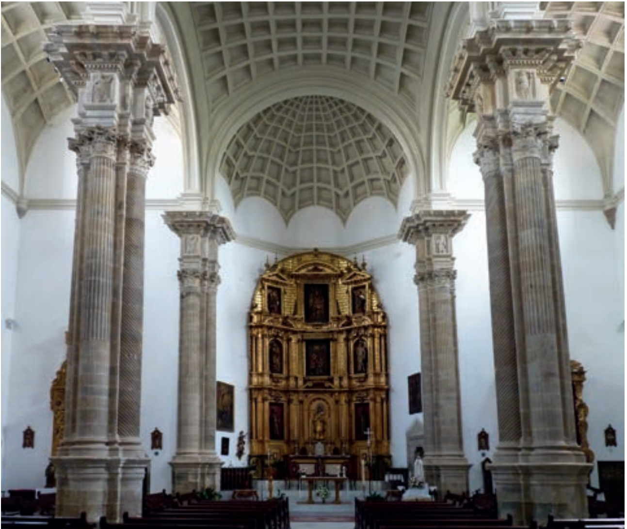
Fig. 18-2. Vista de la ampliación renacentista desde los pies del templo
