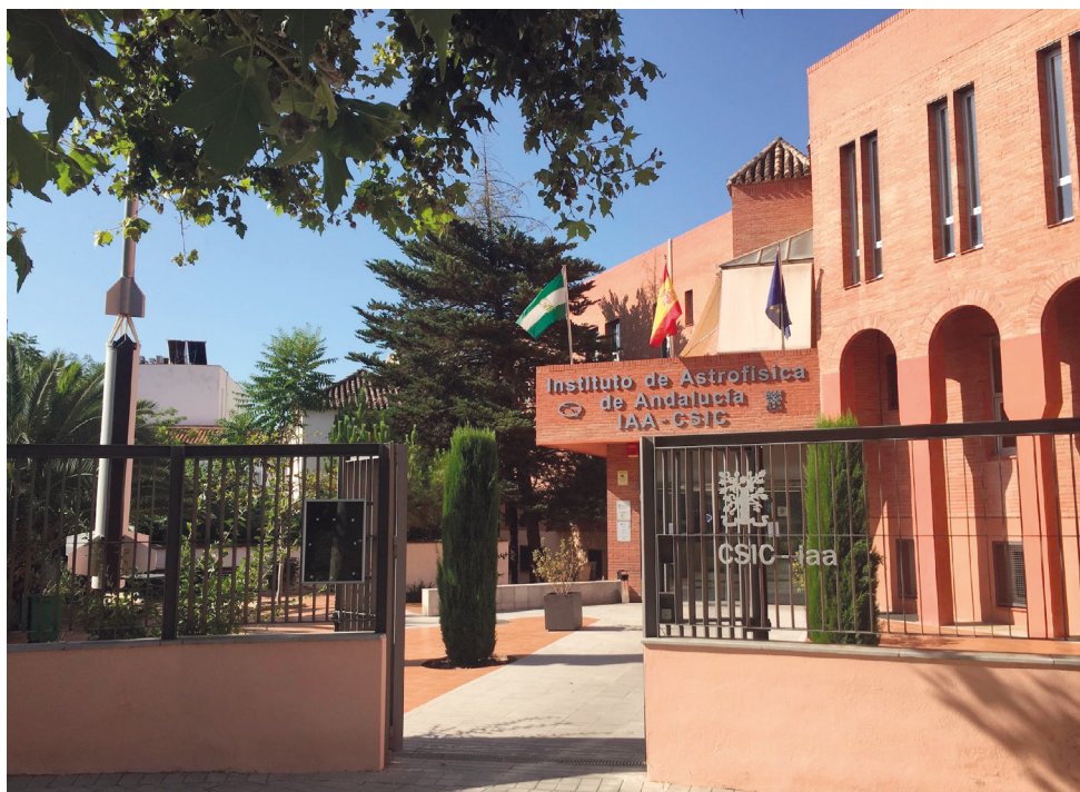
Figura 3. Sede actual del IAA.
