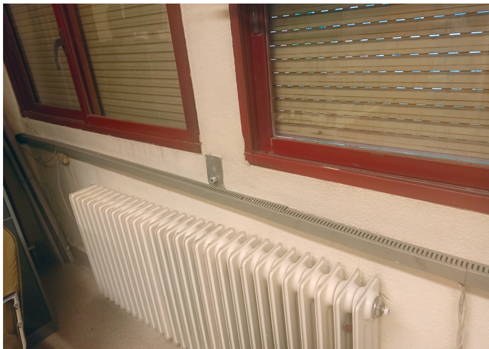
Figura 10. Canaleta de la red RS232 del Departamento de Física Moderna.
