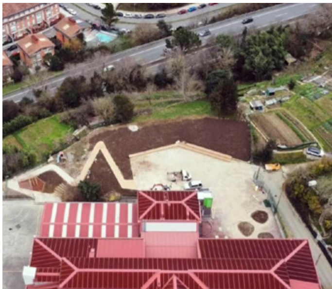
Figura 8. Sistema Lupo (2024). CEP Ibai Ikastola, programa de naturalización de centros educativos de Donostia BERdeaPIZTU. Fase de picado del cemento del patio y reconfiguración de los límites del centro para adaptarse al entorno inmediato. Fotografía independiente.
