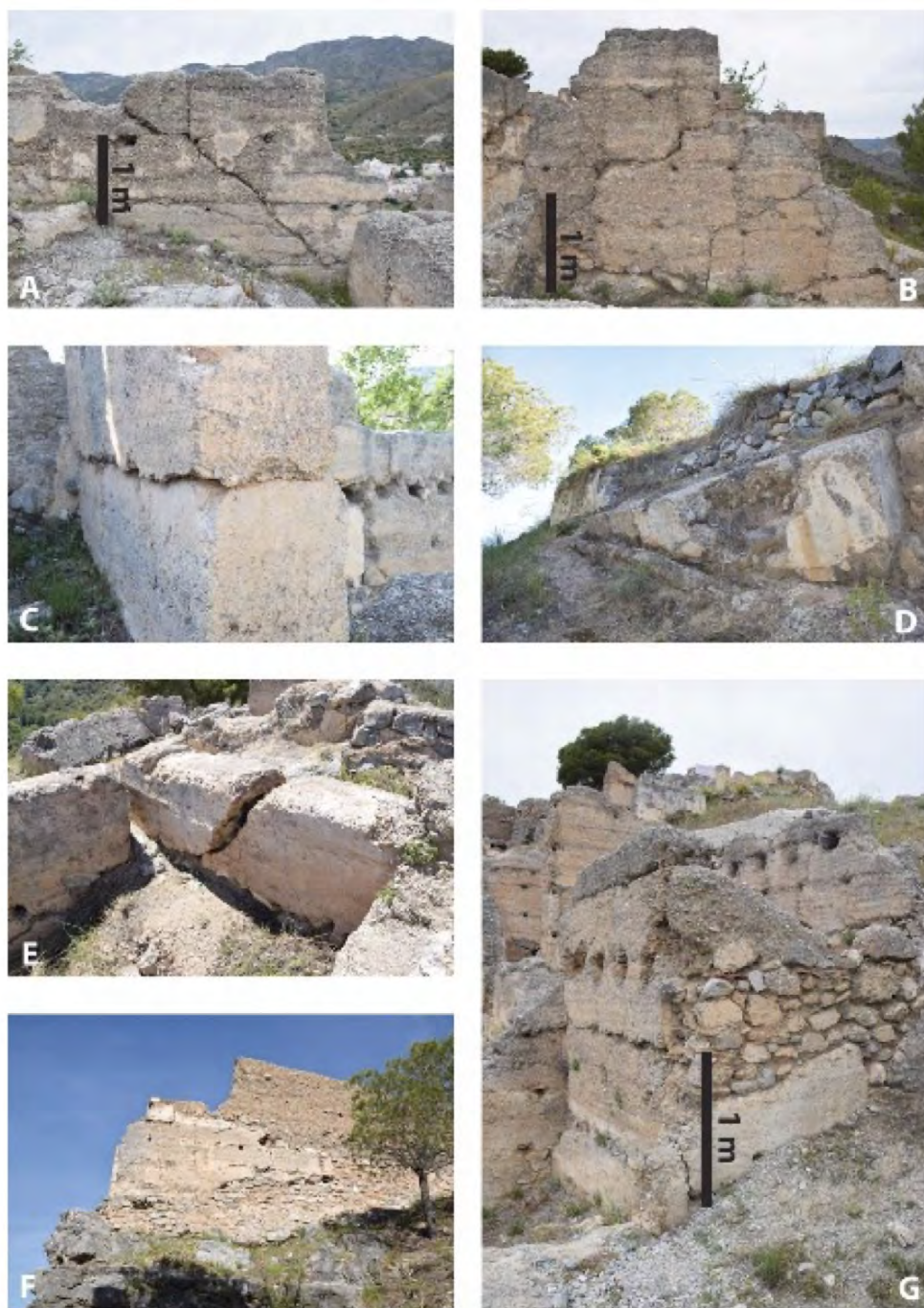
Figura 4. Estudio de las estructuras con fracturas, desplomes, desplazamientos y reparaciones que evidencian la existencia de un terremoto (García Porras y Forlin).
