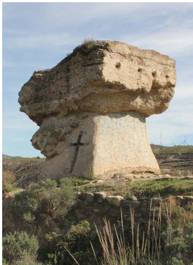
Fig. 5. Castillo de Dúrcal. Restauración con morteros de cemento y descontextualización de su relación con el conjunto fortificado. Fuente: Proyecto PREFORTI (I. Bestué)
