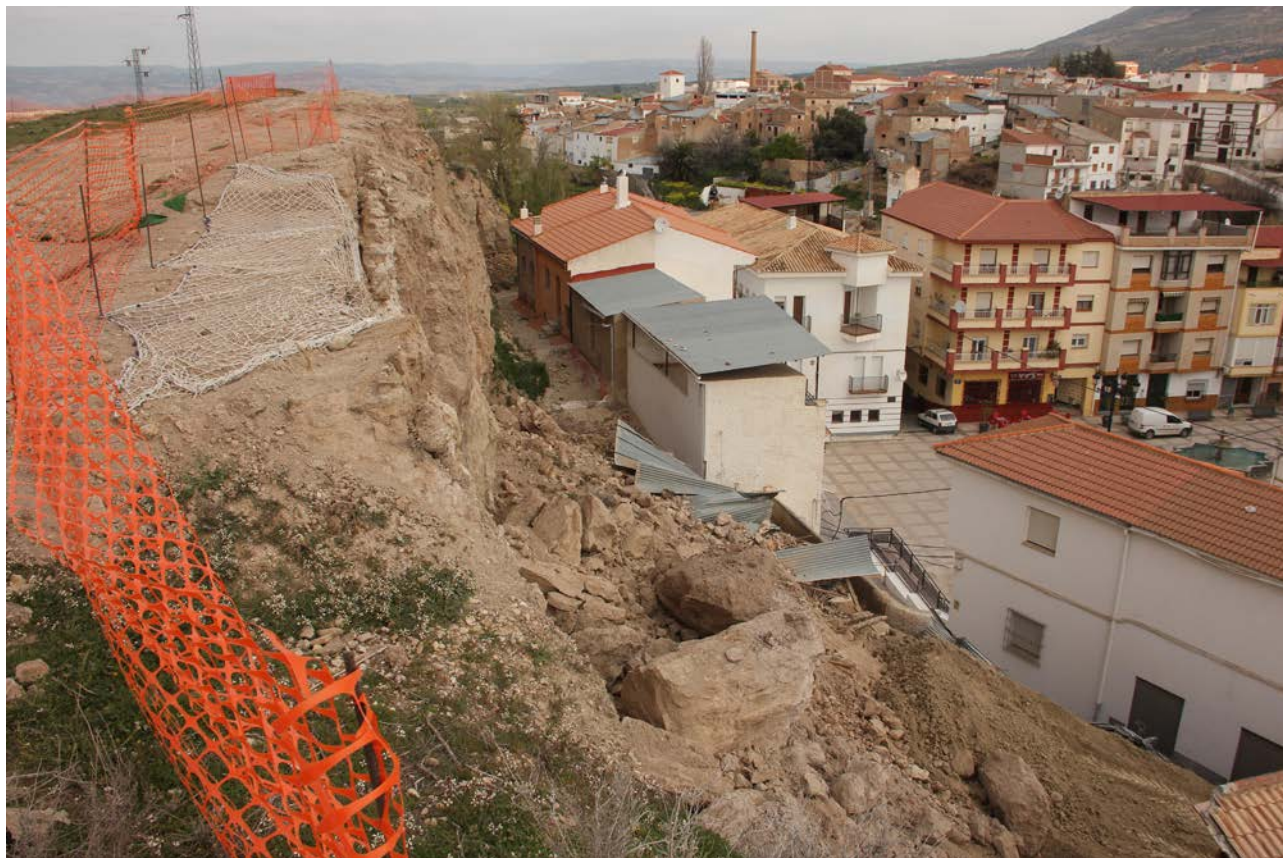
Fig. 6. Desprendimiento de ladera en la alcazaba de Zújar (Granada) en 2017. Fuente: Proyecto PREFORTI (I. Bestué)
