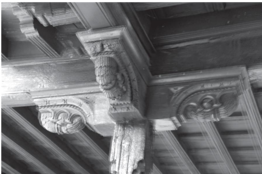
Fig. 1: Anaglifo de un pie derecho perteneciente a la estructura de la Casa del Chapiz (fuente: imagen cedida por José Juan Castro Torres)* Véase N. del A. al final
