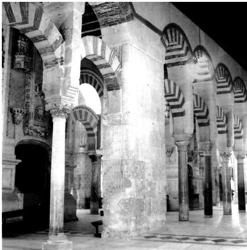
Lám. 4. Muro de la qibla del siglo VIII señalado en el suelo con contrafuerte sobresaliente entre la mezquita de ‘Abd al-Raḥmān I y su ampliación a S. por ‘Abd al-Raḥmān II (Foto, L. Esteban, M. Pijuán y otros).
