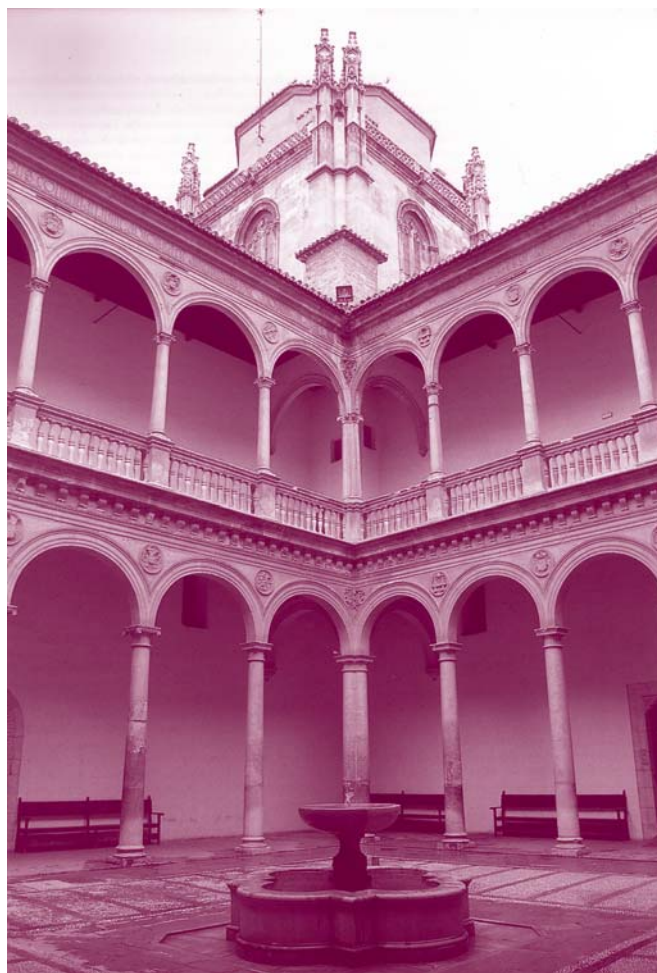
Hospital Real. Patio de los Mármoles
