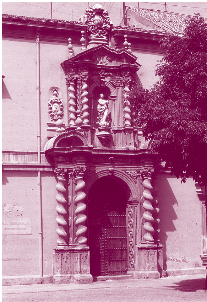
Fachada de la Facultad de Derecho
