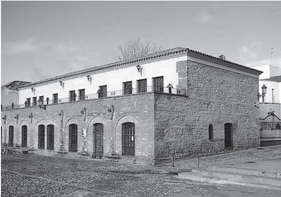
Imagen de la «Casa del Rey» en Arjona (Jaén)
