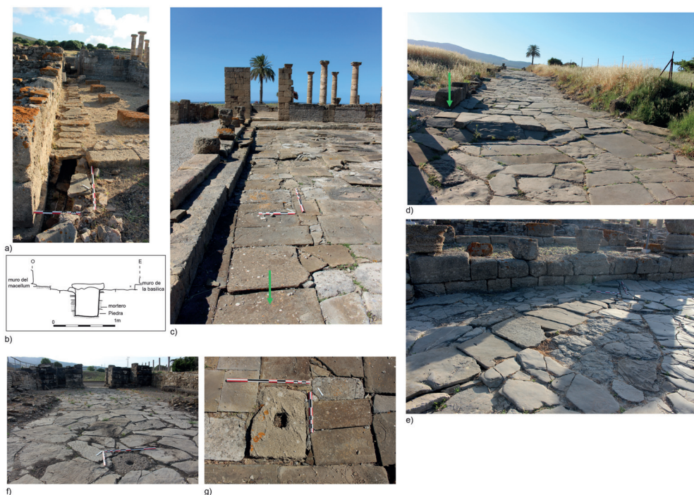
Fig. 8: a) Vista hacia el norte de la cloaca del ambitus occidental del forum en la que desemboca la cloaca del macellum (fotografía de L. Borau) b) Sección transversal de la cloaca (fotografía de L. Borau) c) Vista hacia el sur de la cloaca oriental del foro (fotografía de L. Borau) d) Vista hacia el este del colector que atraviesa el decumanus cerca de la puerta occidental (fotografía de L. Borau) e) Vista hacia el norte del colector que atraviesa el decumanus delante del macellum (fotografía de L. Borau).
